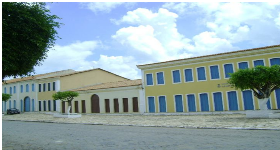
Fig. 2 Quarteirão dos Trapiches, conjunto de edifícios históricos onde funciona atualmente o campus Laranjeiras da Universidade Federal de Sergipe
